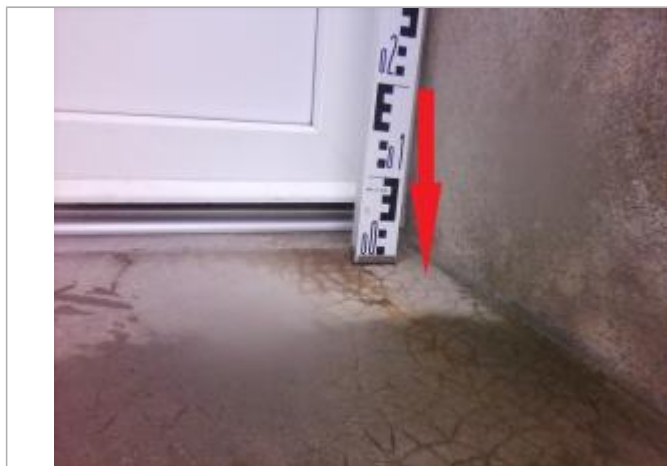
Seuil de la porte d'entrée de la maison / coin du mur
