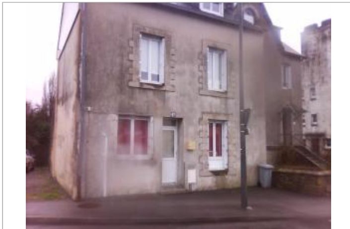
Facade du bâtiment d'habitation
