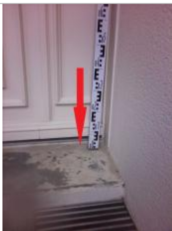
Seuil de la porte d'entrée de l'habitation
