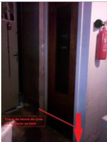
Vue d'ensemble de la porte avec la laisse de crue
