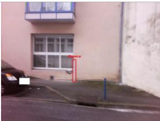
Sol du trottoir sous la fenêtre avant l'angle rentrant du bâtiment
