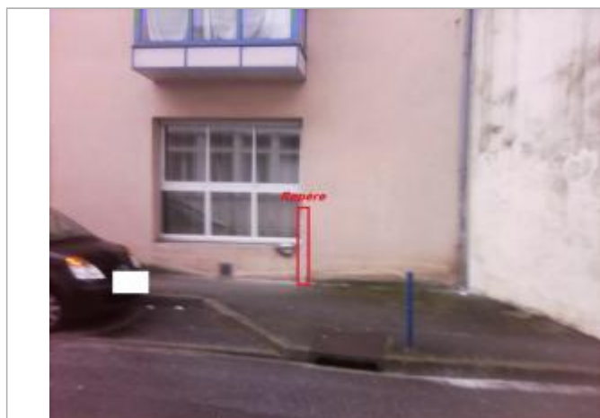
Sol du trottoir sous la fenêtre avant l'angle rentrant du bâtiment
