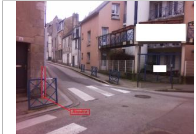
Vue d'ensemble du croisement devant le repère
