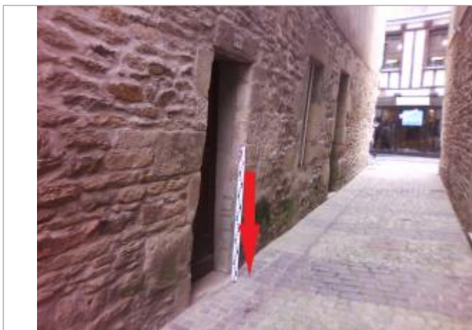
Seuil de la porte du 1 venelle Moulin au Duc
