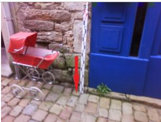
Sol de la venelle au droit de la mire
