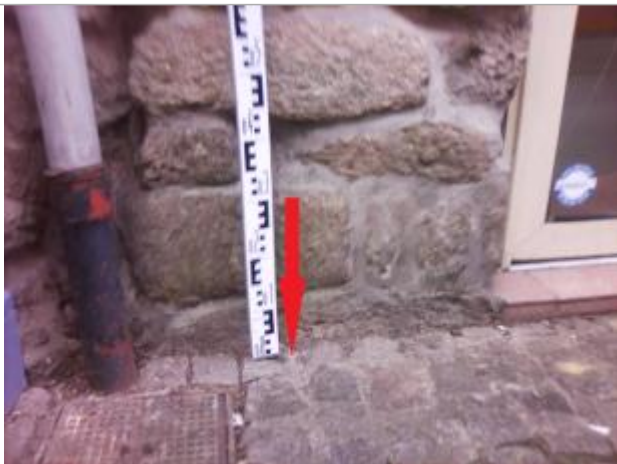
Chaussée entre la descente de gouttière et la porte vitrée
