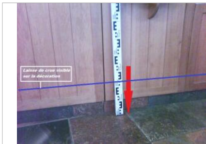
Sol du magasin - seuil d'entrée du magasin
