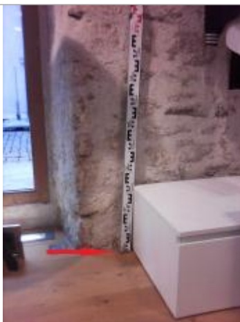
plancher à l'intérieur du magasin
