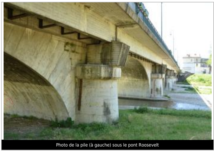
Photo de la pile (à gauche) sous le pont Roosevelt
