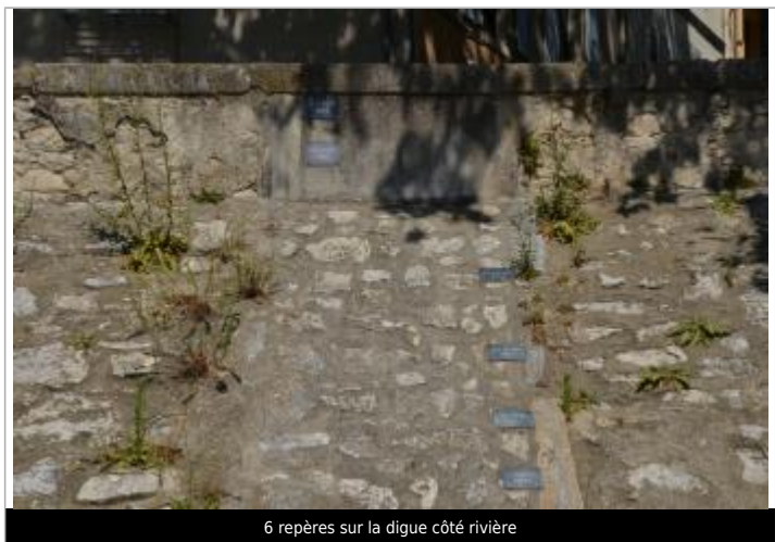
6 repères sur la digue côté rivière
