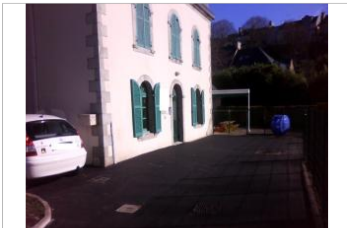
Vue d'ensemble de la façade du bâtiment
