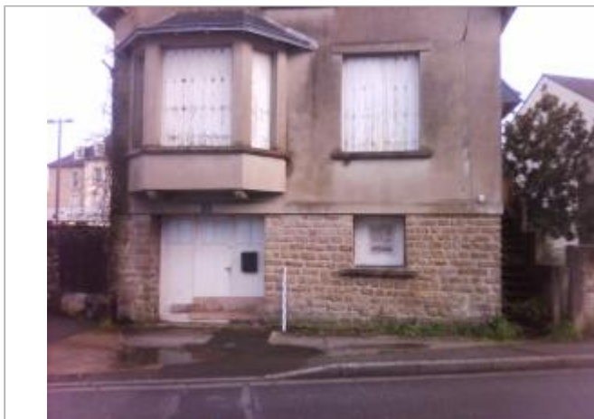
Vue d'ensemble de la façade de l'habitation
