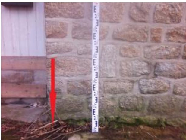
Sol au droit du coin du mur (porte de garage du 4 rue Gambetta)
