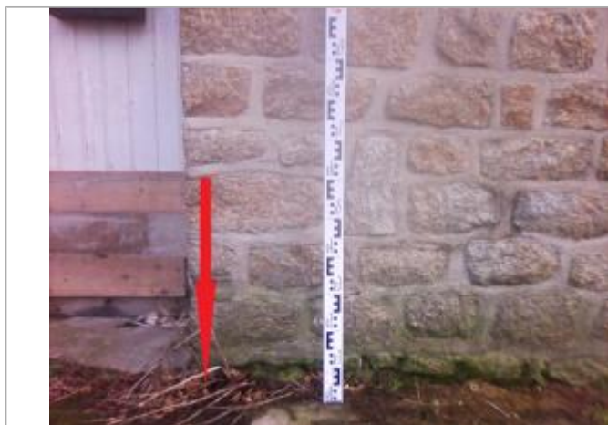
Sol au droit du coin du mur (porte de garage du 4 rue Gambetta)
