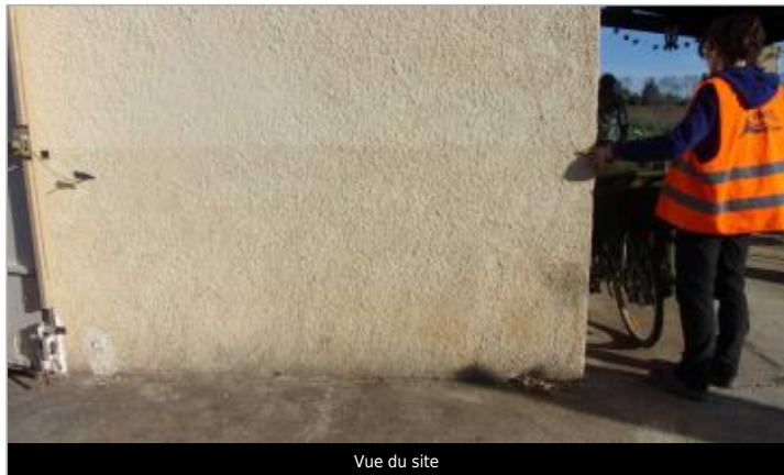
Vue du site
