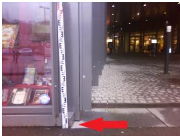
Sol au droit du magasin (donnant rue de la providence)
