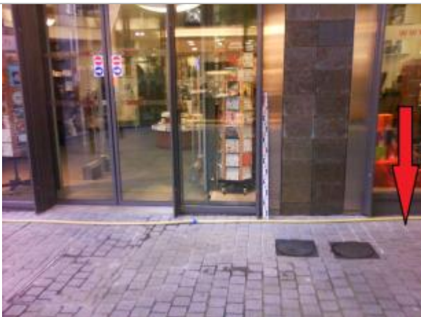
Sol le long de la vitrine dans le passage couvert - à droite de la porte de sortie - sur le montant droit du pilier couvert de céramique.
