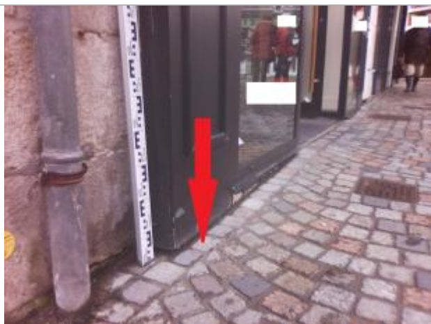
Sol voirie le long des vitrines
