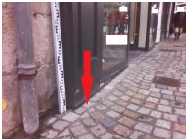
Sol voirie le long des vitrines
