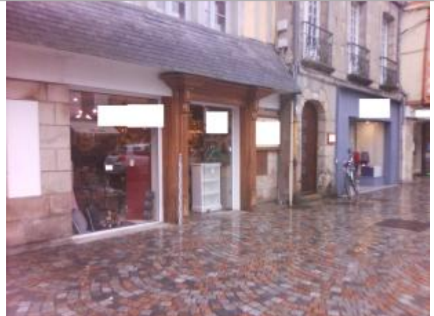
Vue d'ensemble devanture du commerce 4, PLACE TERRE AU DUC
