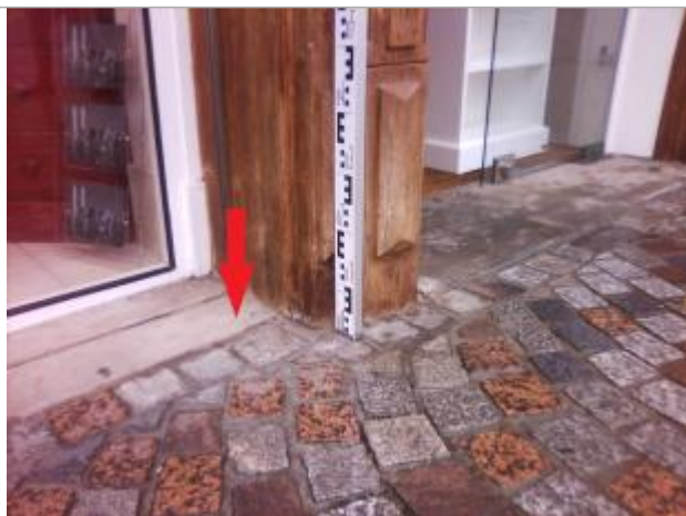
Seuil extérieur du magasin
