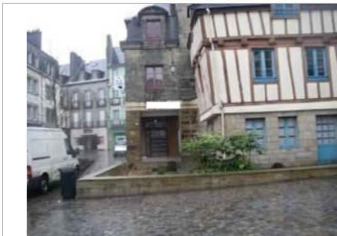
Place Terre Au Duc à côté de l'entrée de l'agence bancaire au niveau du petit muret
