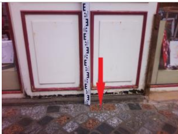
Seuil de la porte du magasin
