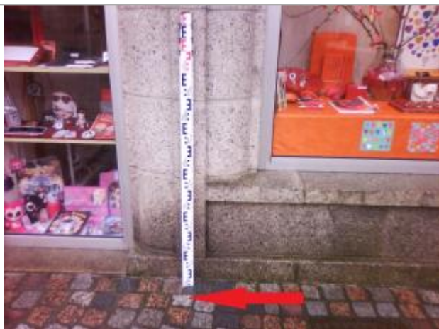
Sol au droit du mur de façade (entre la grande et la petite vitrine)
