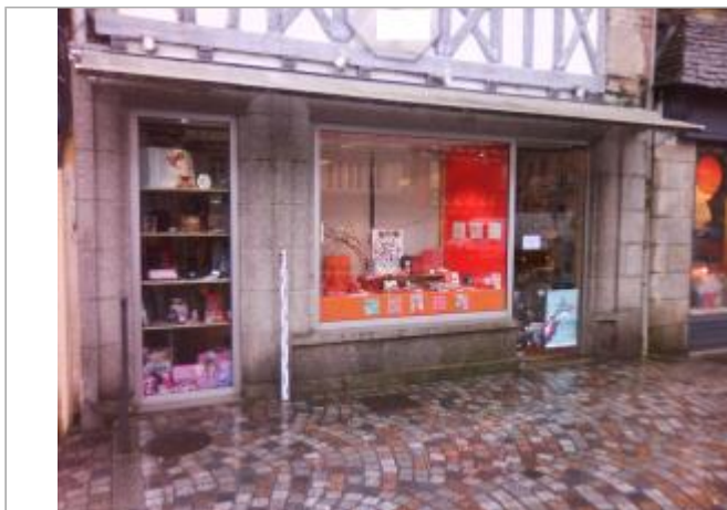
Vue d'ensemble de la devanture du bâtiment de commerce
