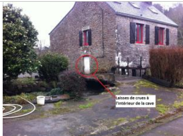
Vue d'ensemble du bâtiment d'habitation , 19 , allée du Moulin Saint Denis
