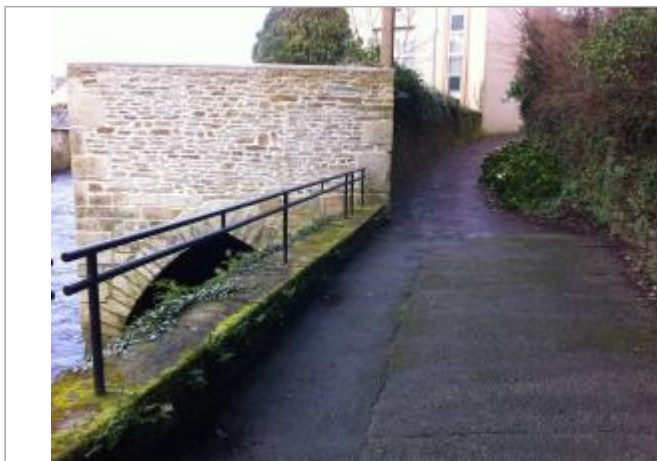
Vue d'ensemble du mur de l'arche rue de l'ancien abattoir
