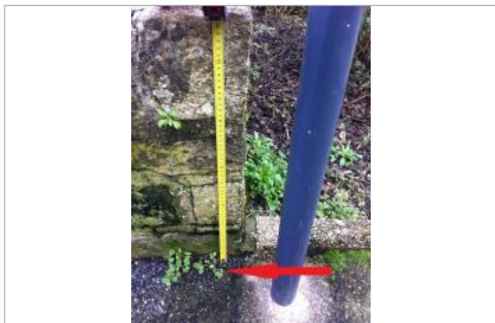
Sol au droit du muret
