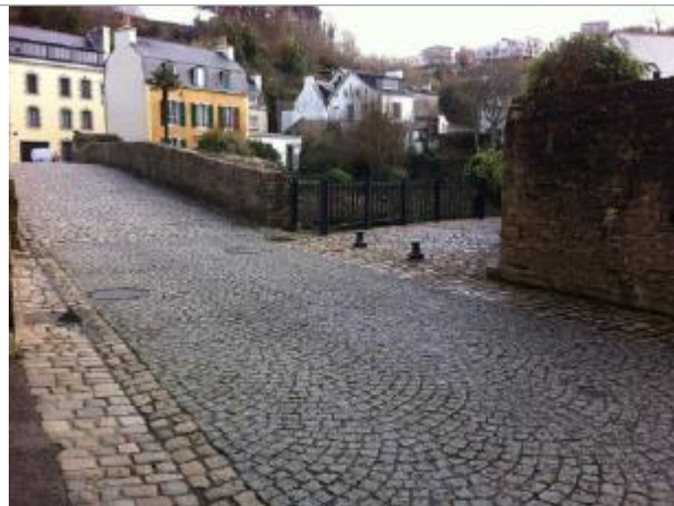
Garde-corps du pont rue Ellé
