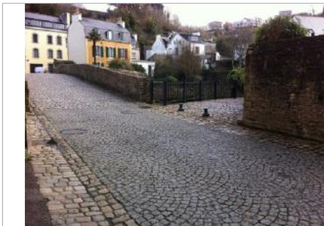
Garde-corps du pont rue Ellé
