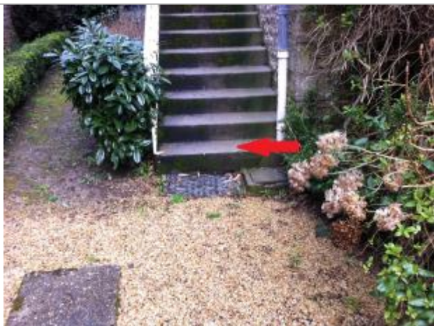
1ère marche de l'escalier depuis le bas ( côté jardin )
