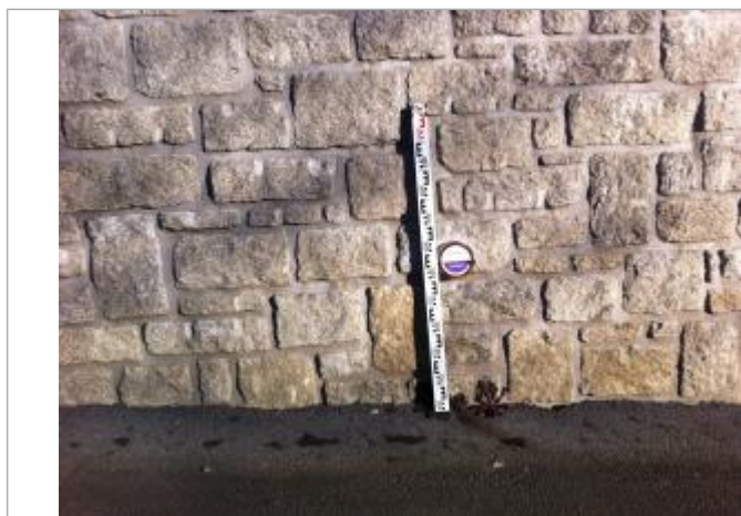
Bâtiment principal station AEP_cruce 08 02 2014 avec macaron de janvier 1995 (PHEC)
