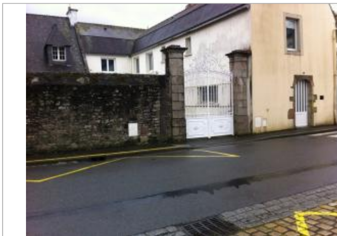
Vue d'ensemble portail d'entrée. 38T rue Bremond d'ars
