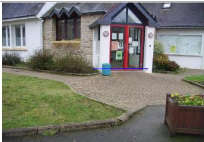
Entrée ouest Mairie st nolff
