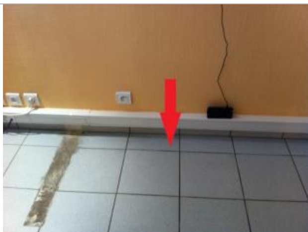
Plancher du bâtiment / bureau
