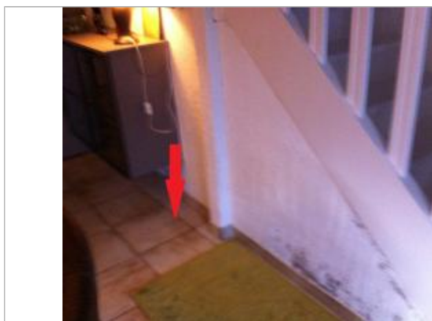
Plancher de l'habitation
