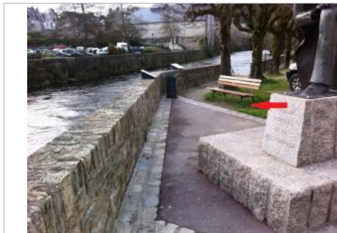
Sol au droit du banc
