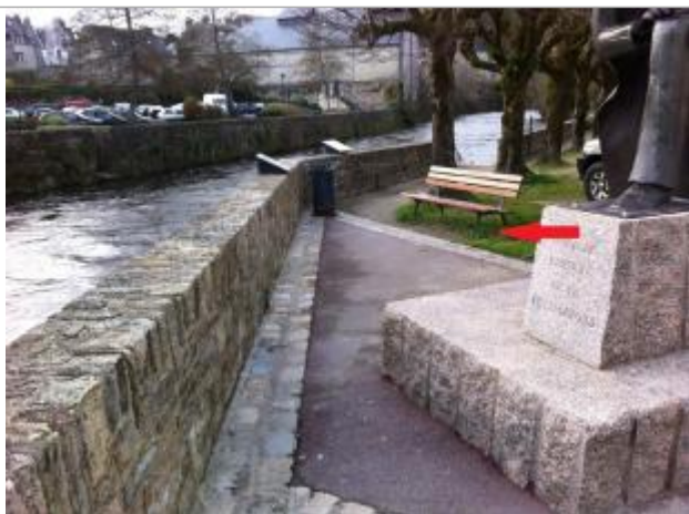
Sol au droit du banc
