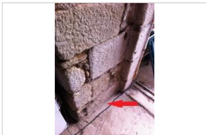
Sol de la cave au droit du mur
