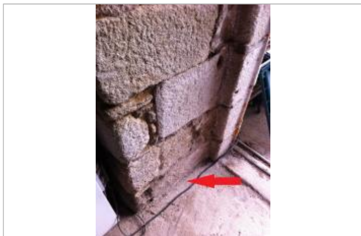
Sol de la cave au droit du mur
