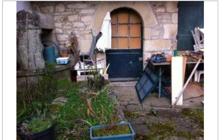
Cave de bâtiment d'habitation
