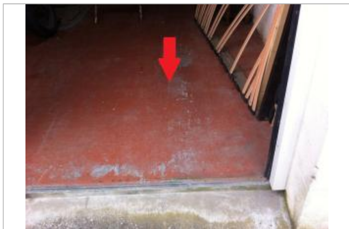
Plancher de garage
