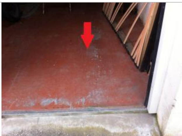
Plancher de garage
