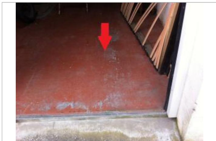
Plancher de garage
