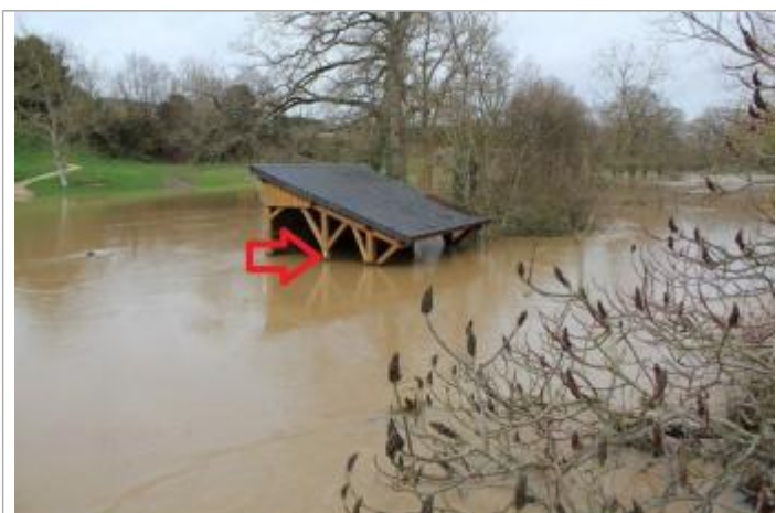
niveau d'eau en-dessous des arches du lavoir
