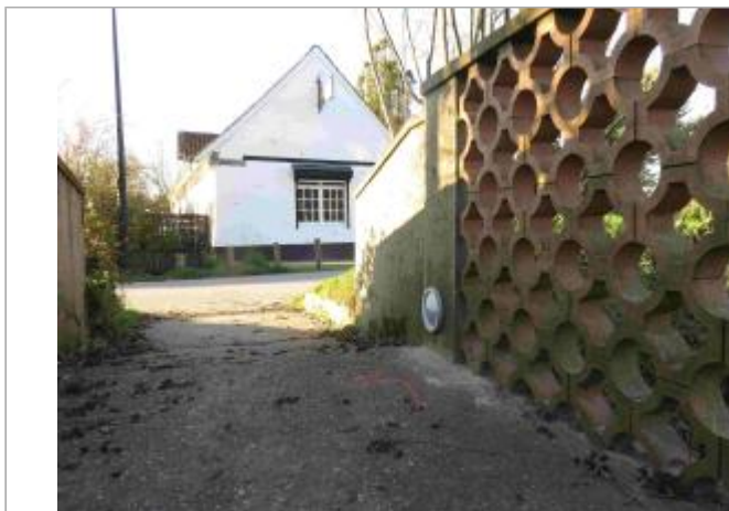
Passerelle de la Grenouillère
