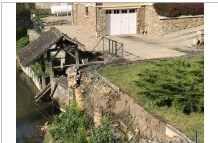
Traces au sol de la coulée de boue en provenance du chemin de la cavée
