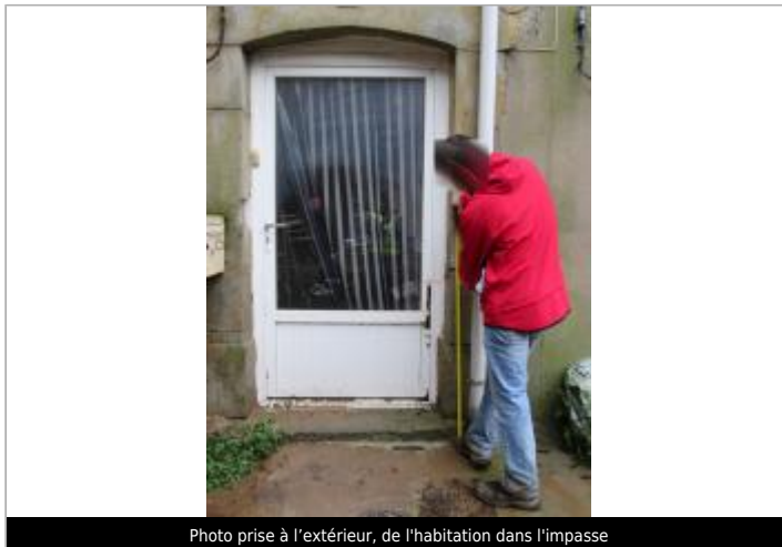
Photo prise à l'extérieur, de l'habitation dans l'impasse
