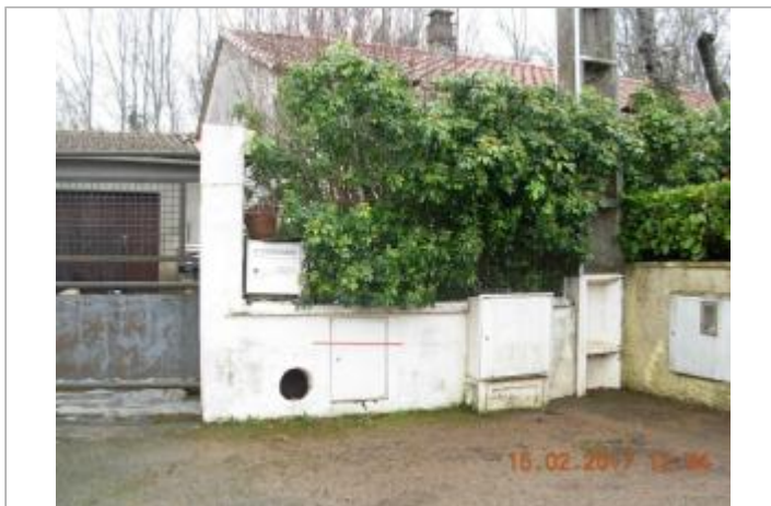
Mur de clôture
