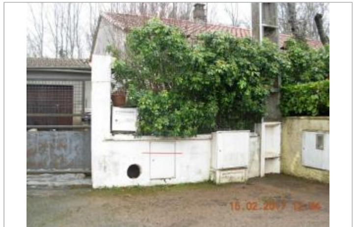
Mur de clôture
