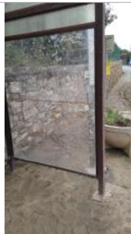
Photo prise à l'extérieur, dans la rue
