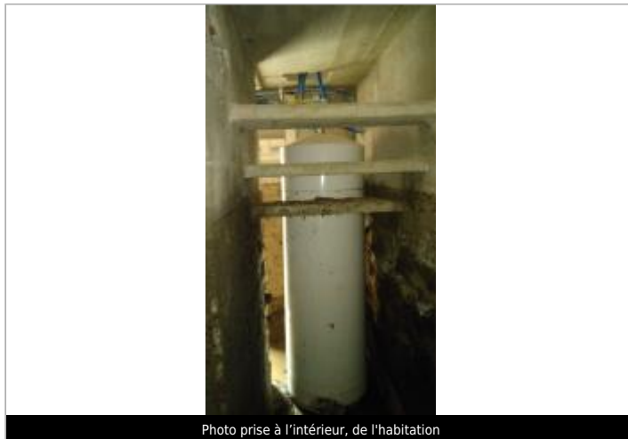
Photo prise à l'intérieur, de l'habitation
